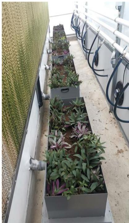
**Figura 1.** Ejemplo de biofiltro instalado en un invernadero prototipo (CARTIF, SingularGreen)
